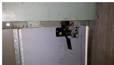
Serrure de porte palière du niveau principal
