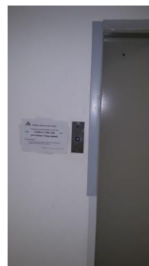
Commande palière du niveau principal
